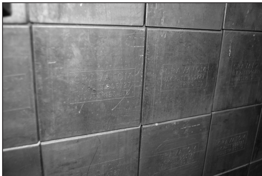
En del av blyväggen som avskärmar labbet för högstrålning. Den här bilden blir faktiskt inte roligare i färg
